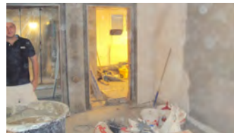
Durchgang UG zum Sunnegarte
